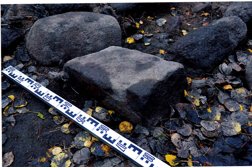
Kirkon kivijalka on tehty muokkaamattomista luonnonkivistä. Kuvassa kirkkosalin koilliskulman nurkkakivi.
